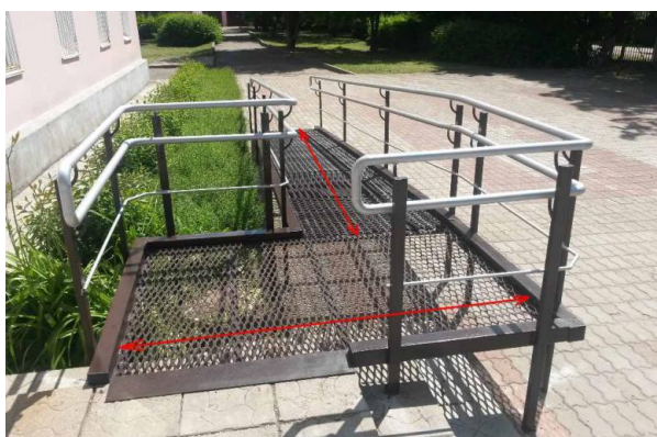
Рисунок 3.16.4 – Пример оборудования объекта пандусом для МГН
