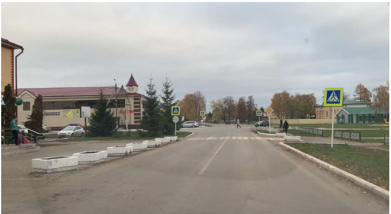
Рисунок 1.3.5 – Состояние покрытия автомобильной дороги в рп. Атяшево, улица Ленина
