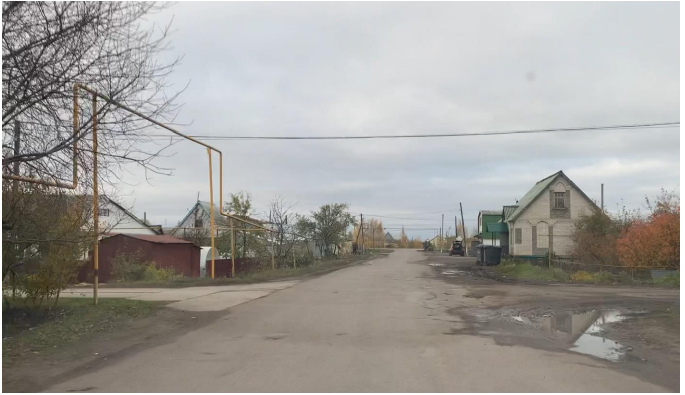
Рисунок 1.3.2 – Состояние покрытия автомобильной дороги в рп. Атышево, Транспортный переулок
