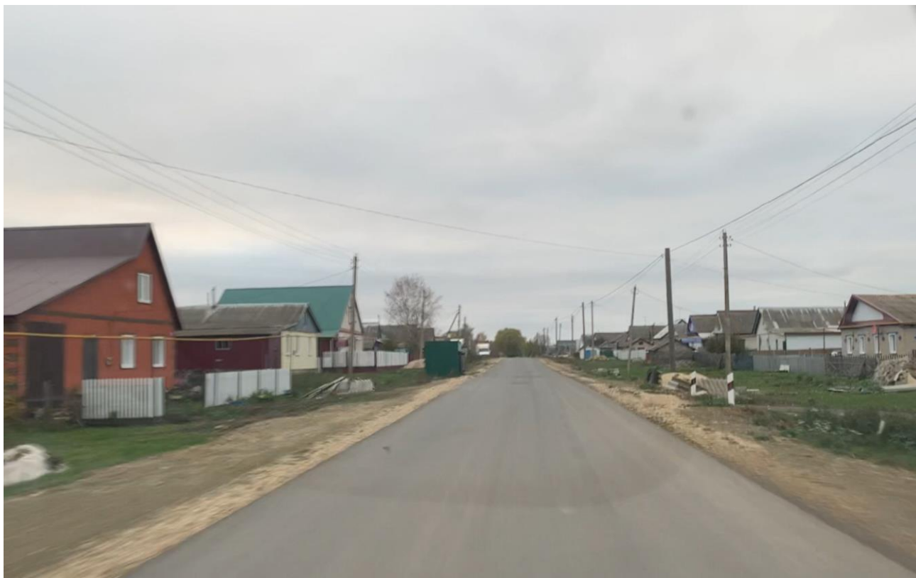
Рисунок 1.3.14 – Состояние покрытия автомобильной дороги в с. Атяшево, Первомайская улица
